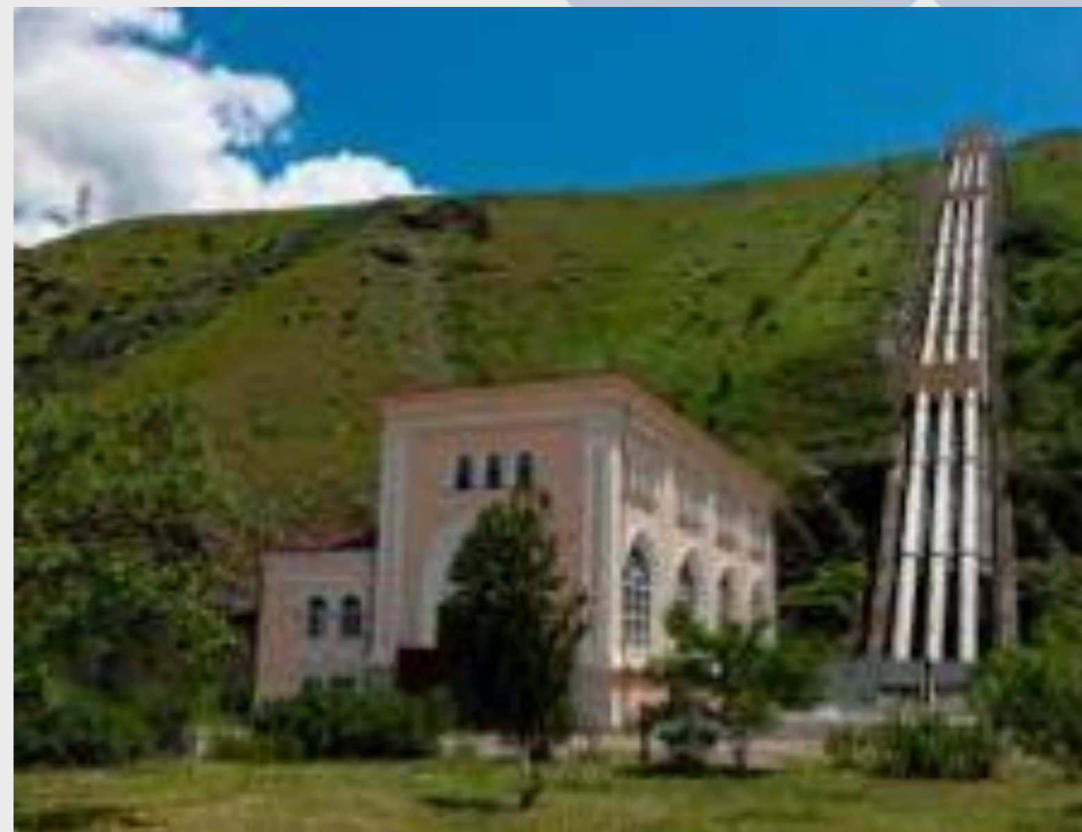
Комплексная АСУТП Эзминской ГЭС (2023)
